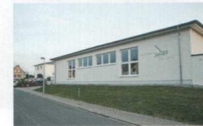
Nach Fertigstellung des fünften Bauabschnitts im März 2013 verfügt Johst jetzt über 2.100 m 2 in Wermsdorf – 50 km östlich von Leipzig.
